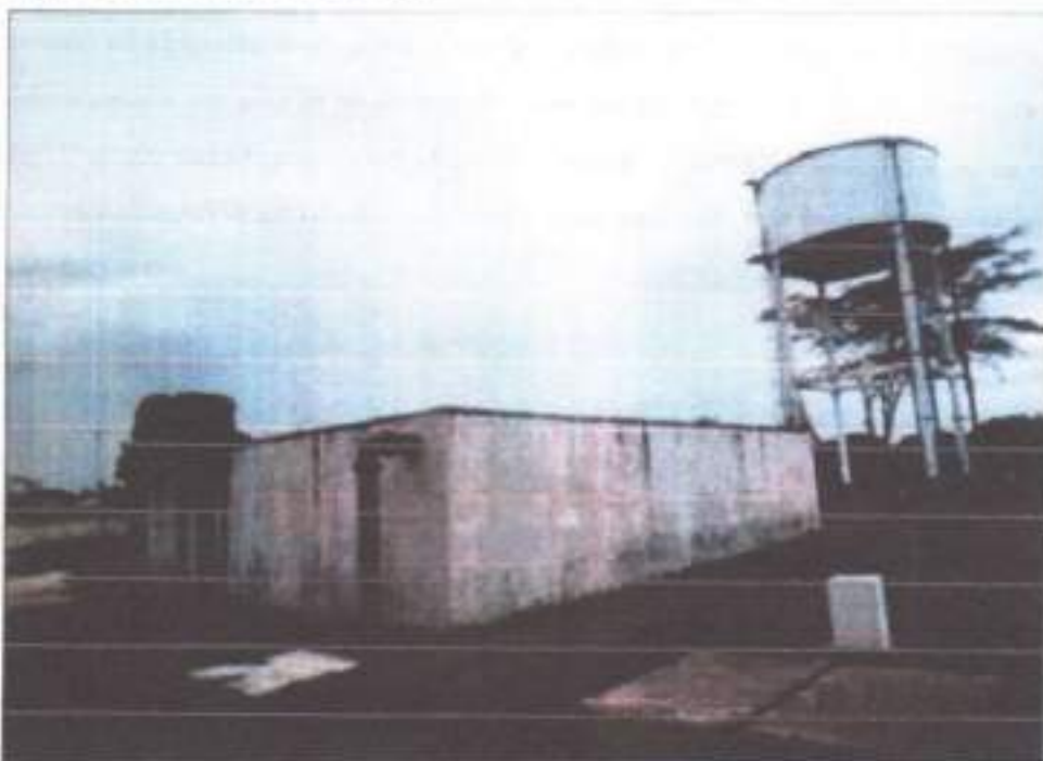
Figura 5.8: Reservatórios da Sede
