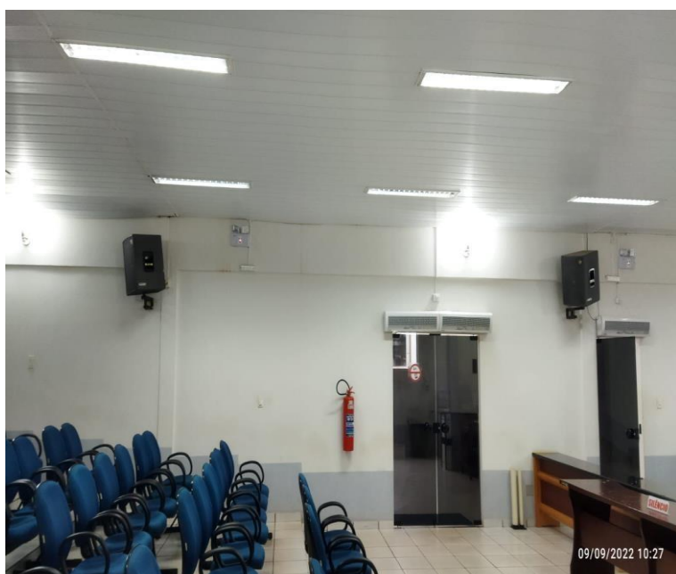
02 Caixas de som do lado da porta de entrada principal para manutenção.
